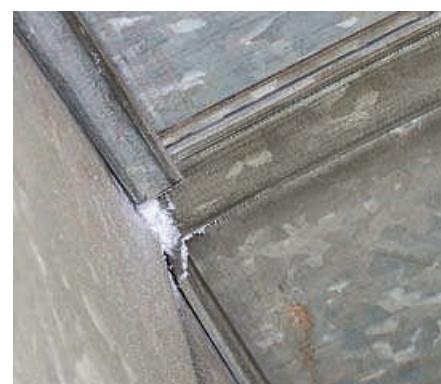
Das Verfahren dichtet Leckagen von bis zu 15 mm Durchmesser mit lebensmittel-echtem Kunststoff ab.
