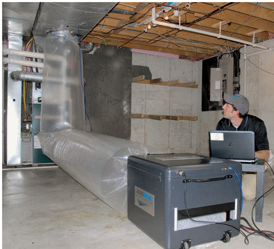
Ein in den USA bewährtes Verfahren zur Luftkanal-Abdichtung kommt nach Europa: MEZ-Aeroseal.
