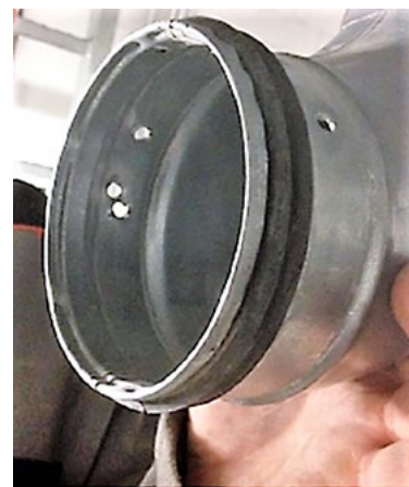
◀ Bild 5 • Löcher, die bei Montagen nach dem „Try and Error“-Verfahren entstehen, werden in vielen Fällen nicht abgedichtet, sondern verbleiben als Leckagen im Luftleitungssystem.
