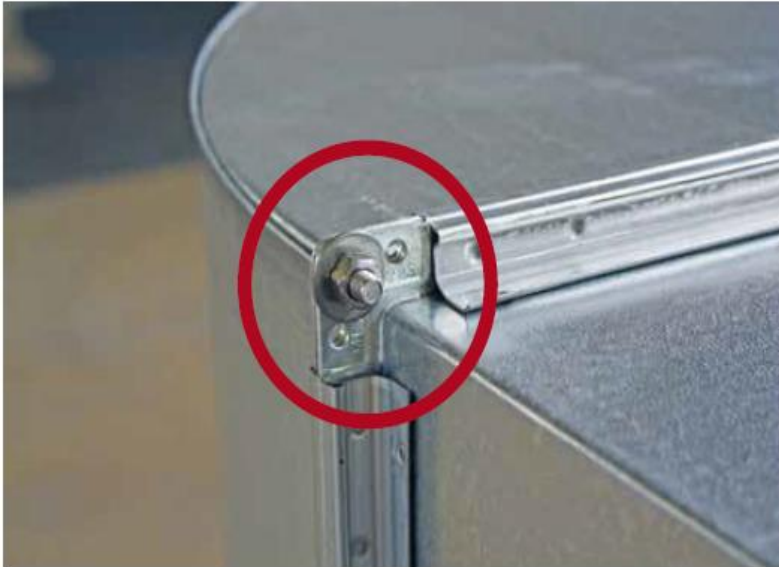
Der Dichtstoff setzt sich auch an undichte Falze.
